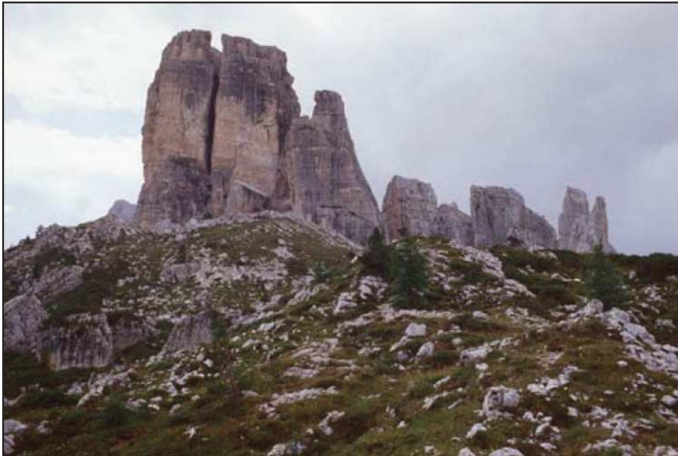
Figura 4.16 Dolomiti: le Cinque Torri prima del crollo della Torre Trepbor (2004) e dei crolli che hanno interessato la Torre Inglese (2008). Fotografia di A. Bini.
